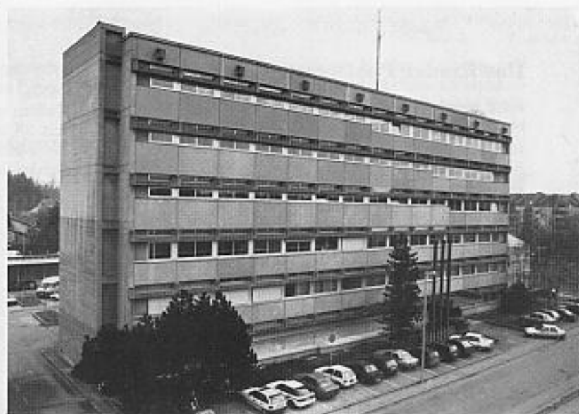
Das 1974 bezogene neue Fernmeldegebäude in der Schillerstraße.
